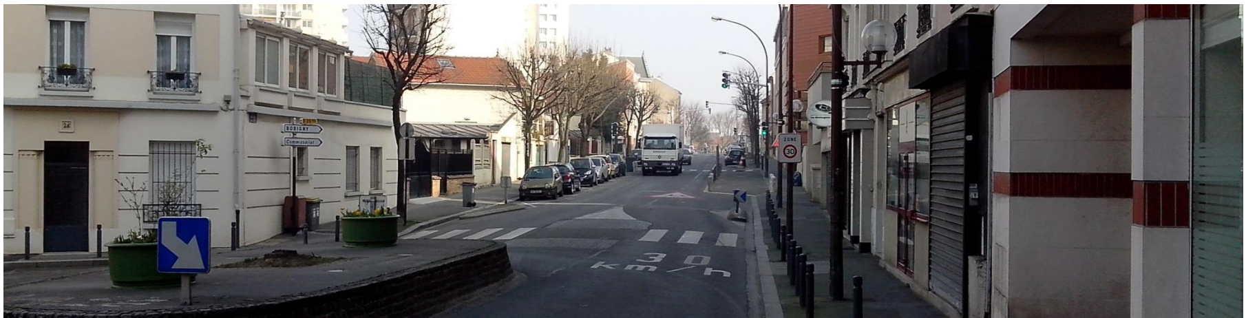
Une entrée en zone 30 couplée à un marquage au sol et à un rétrécissement de voirie.
